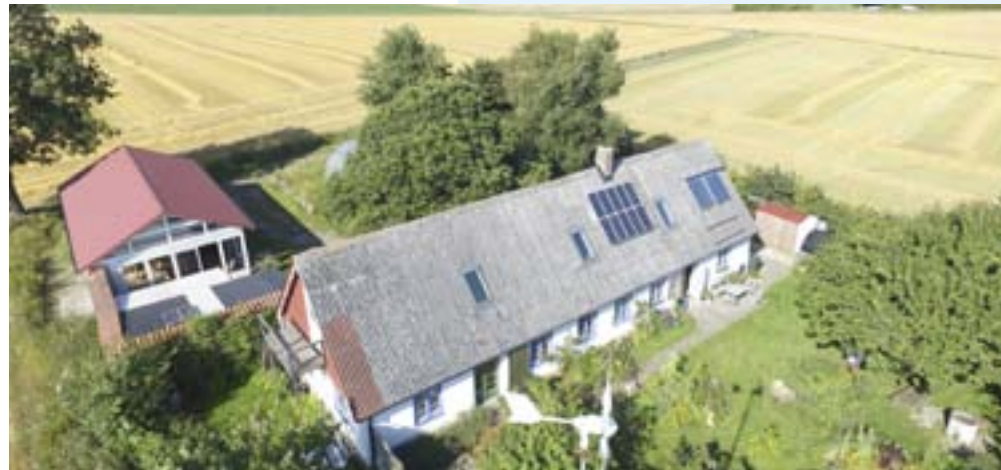
På taket har paret Wendt installerat solfångare av modell vakuumrör.
