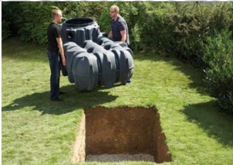
Installation av en regnvattentank: Tanken kopplas på dagvattenledningen, så vattnet från alla stuprör och dränering samlas i den.
