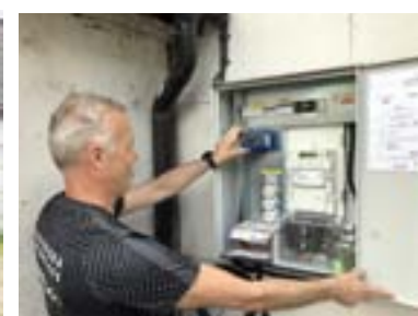
Elskåpet har kompletterats med ny mätarutrustning för sole och energilagring.
