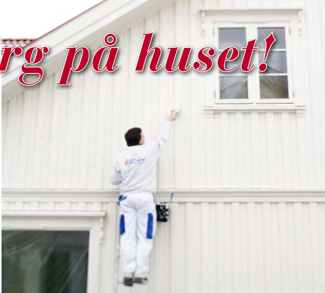
Grundregeln när du målar en träfasad är att använda samma färgtyp som huset tidigare målats med.
