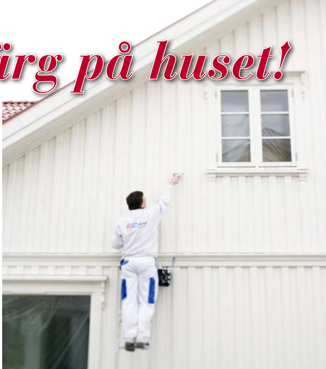
Grundregeln när du målar en träfasad är att använda samma färgtyp som huset tidigare målats med.
