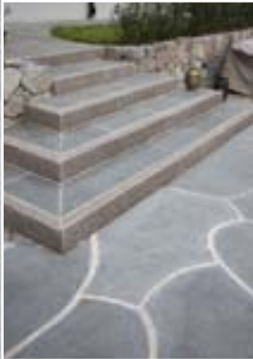
Oregelbundna plattor i kombination med regelbundna i trappan.
