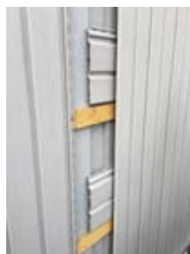
Fasad monterad direkt på lockpanel.
