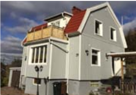
Kaycan PVC fasad efter montering.
