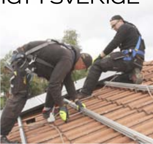
PPAMs installatörer utför installation på södersidan av familjen Kremsls tegeltak.
