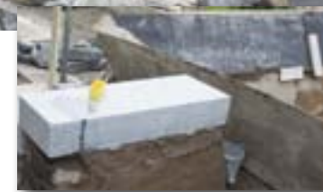
Granittrappan står stabilt på grunden av sprängsten.
