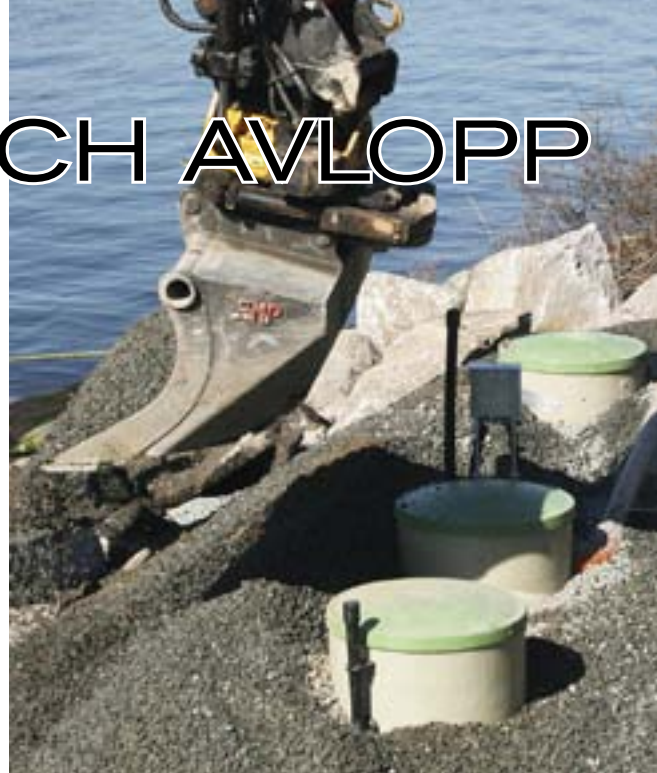
De största problemen uppstår där vattnet är väldigt mjukt och även där avsättning är nödvändig.
