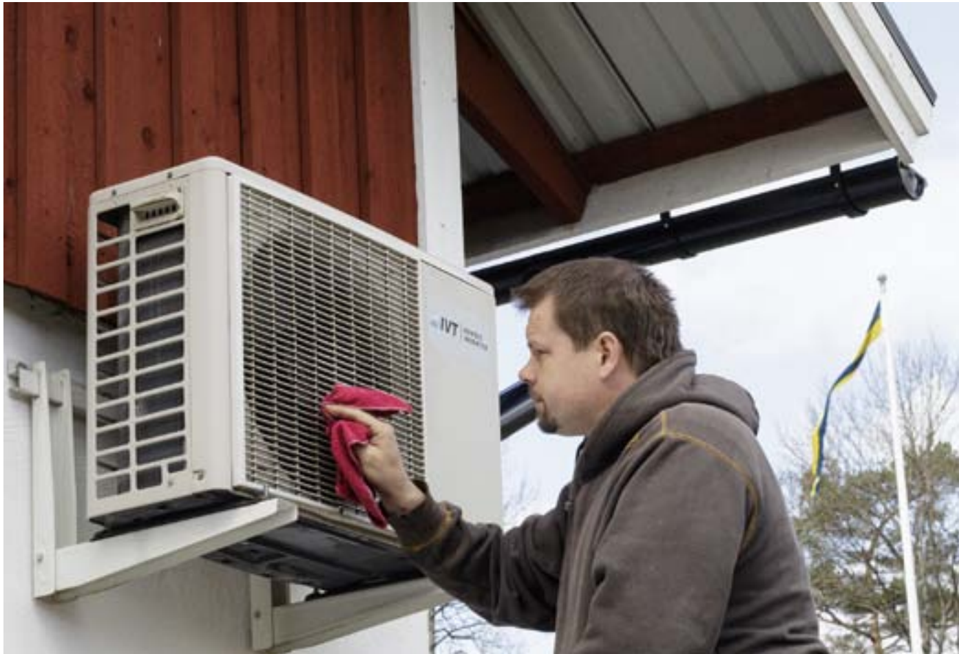
Luft/luftvärmepumpar kräver regelbunden skötsel av både inomhus- och utomhusdelen. Det ökar värmepumpens livslängd och förbättrar effektiviteten.
