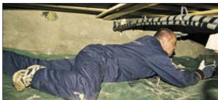
Utrymmen i grund och källare bör undersökas extra noga.
