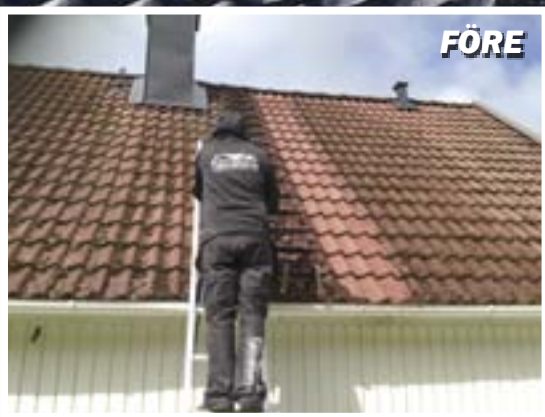
BYTE AV FÄRG PÅ TAK
