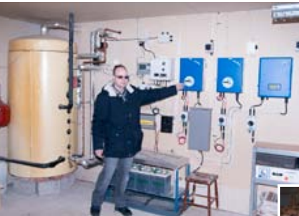
Peter håller koll på energileveranserna i garaget, där solvärmen leds till tanken och solelen till växelriktarna.
