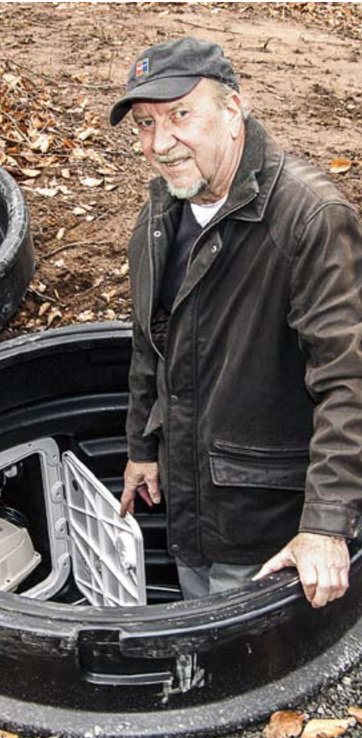
Hisingsbon Allan Eriksson har bytt ut sin gamla trekammarbrunn mot ett minireningsverk som uppfyller kommunens miljökrav.
