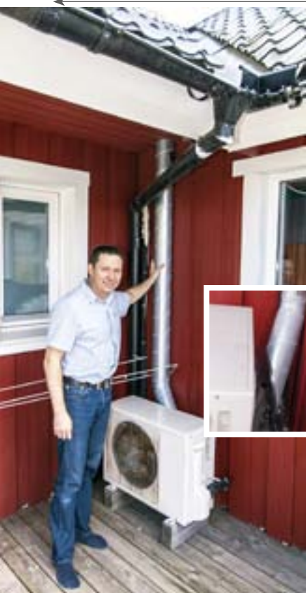
Robert leder ut frånluftsvärmen från huset till luft/luftvärmepumpen, vilket ökar pumpens effektivitet betydligt.
