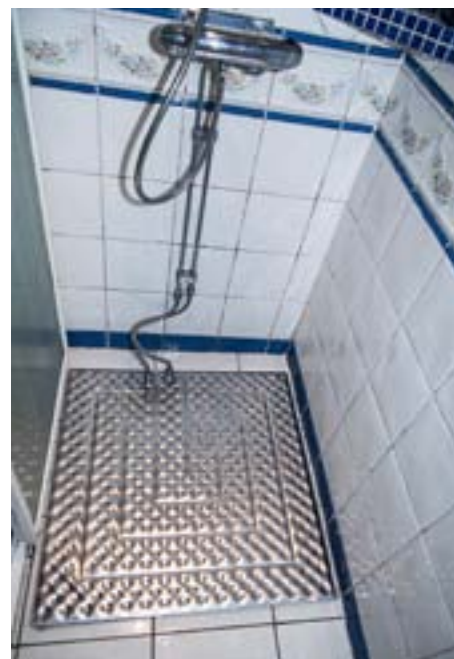
"Var tredje dusch blir gratis" tack vare värmeväxlaren i duschutrymmet
