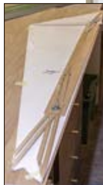
Robert Rundberg visar ett färdiggjort steg, som limmas fast. Man kan även klä trappstegens undersida om den är synlig.
