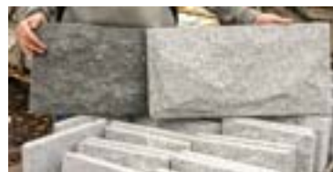
En kallmur i ottaskiffer (bygger 5-20 cm djup).
