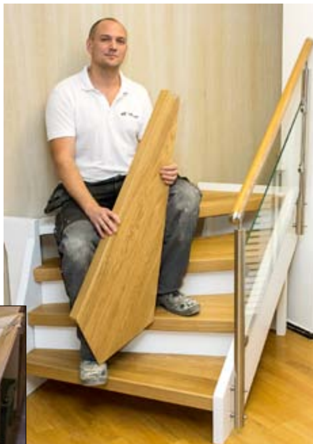
Robert Rundberg visar ett färdiggjort steg, som limmas fast. Man kan även klä trappstegens undersida om den är synlig.
