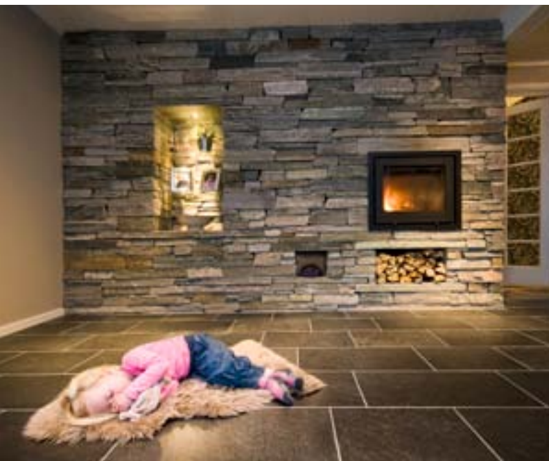
En kallmur i ottaskiffer (bygger 5-20 cm djup).
