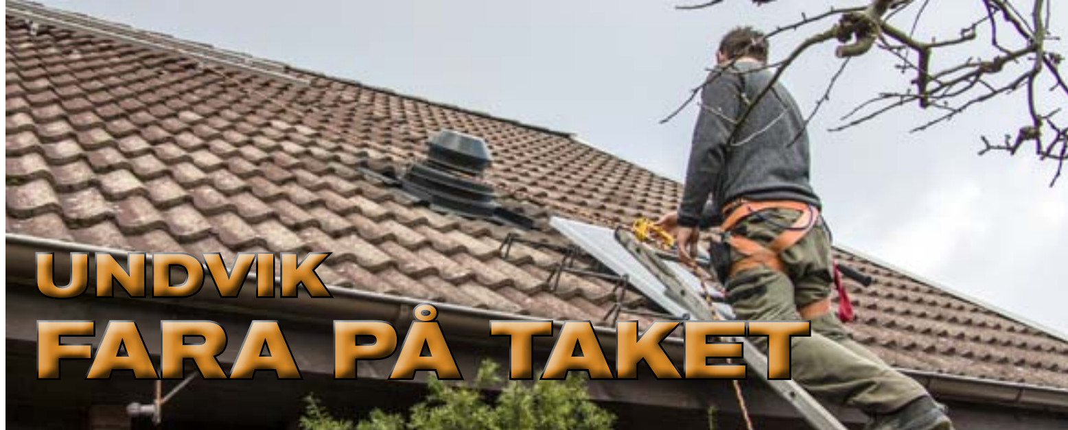
Kraven på säkerhetsanordningar för taket varierar beroende på husets fasadhöjd, takets lutning och när huset är byggt.
