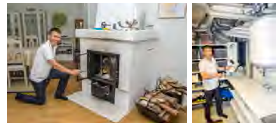
Effektiva värmekällor. Mikael kombinerar en vattenmantlad kamin med ett ventilations-system som återvinner frånluftsvärmen inomhus.
