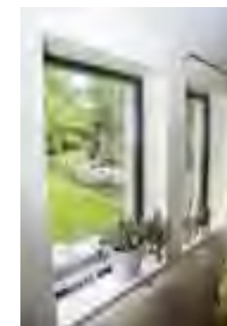
Välisolerat. Väggisoleringen gör att fönsternischerna blivit lite djupare än vanligt.
