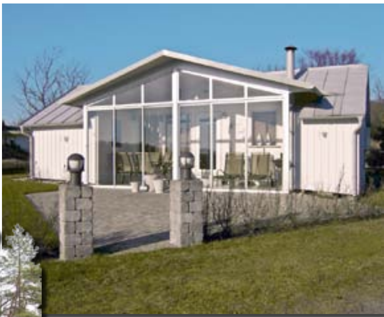
Har du höga elkostnader lönar det sig ofta att installera en extra värmekälla som avlastar eluppvärmningen.
