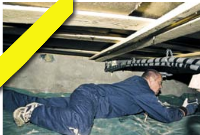
Om det finns kryputrymme i grunden kan du prova att inspektera invändigt med en ficklampa.
