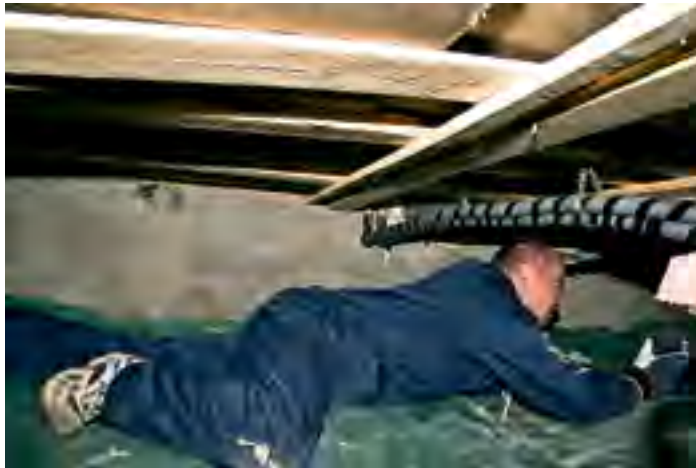
Om det finns kryputrymme i grunden kan du pröva att inspektera invändigt med en ficklampa.
