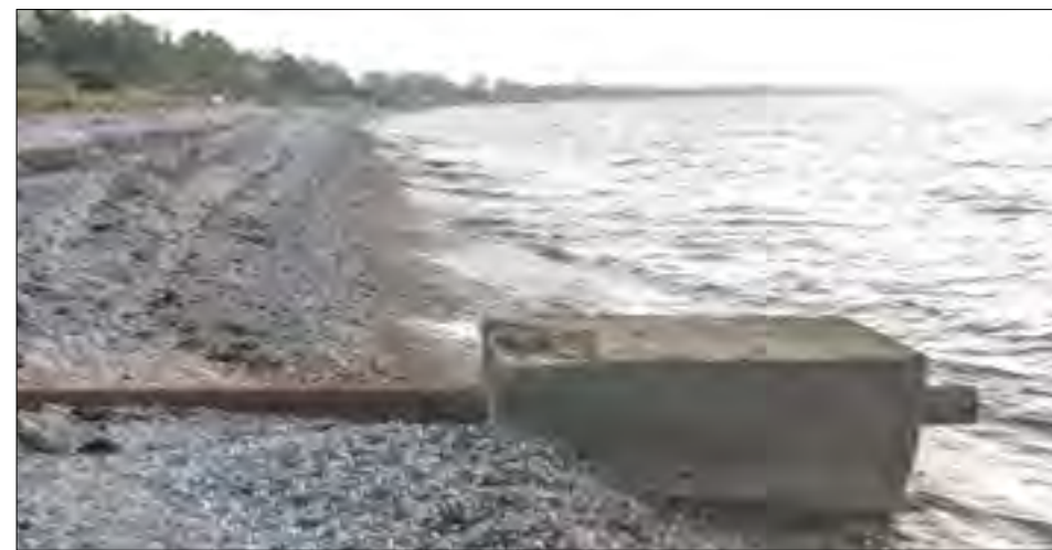
Utsläpp från små avlopp bidrar till övergödningen i hav och vattendrag.
