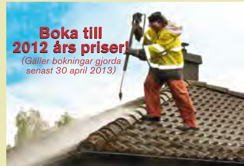
Innan takpannorna impregneras tvättas de först med ett pH-höjande tvättmedel som avlägsnar all smuts och påväxt.
