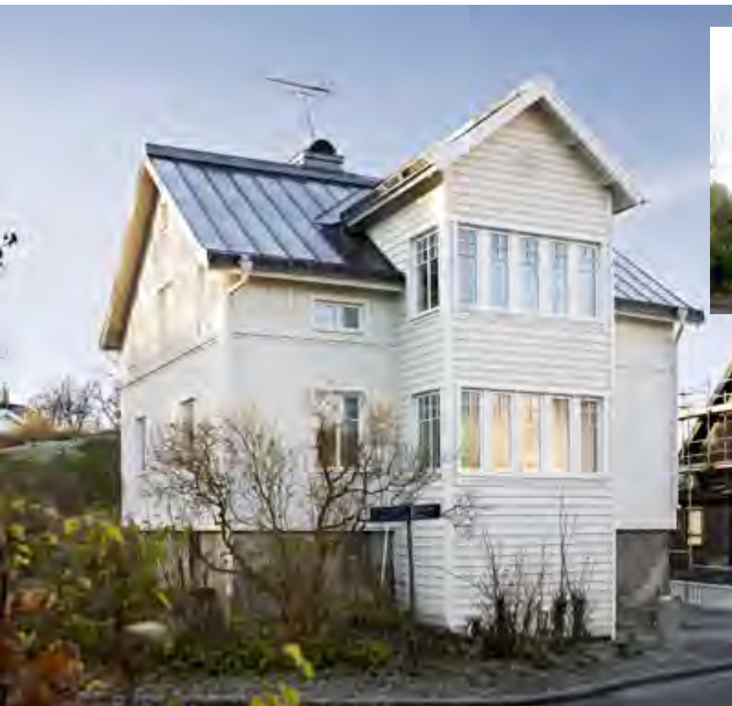
Från ruckel till drömkå. Wictoria Ostrelus ombyggnadsprojekt innebar en kompromiss mellan modernisering och hänsyn till den ursprungliga stilen i arbetarkvarteret. Träfasaden har återskapats i vacker jugendstil
