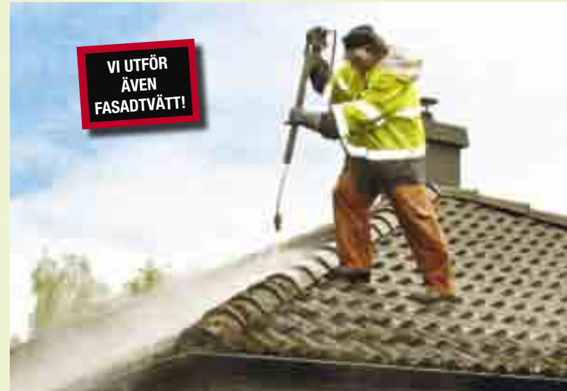
Innan takpannorna impregneras tvättas de först med ett pH-höjande tvättmedel som avlägsnar all smuts och påväxt.
