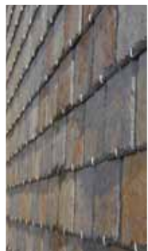
På det här huset har skifferplattor från Nordskiffer av typ Samaca Multicolor använts på både tak och fasad. Plattorna sitter i så kallad "dubbeltäckning". På både tak och fasad har rostfri stormkrok använts. På fasaden är takskiffen monterad på läkt med luftspalt bakom.
