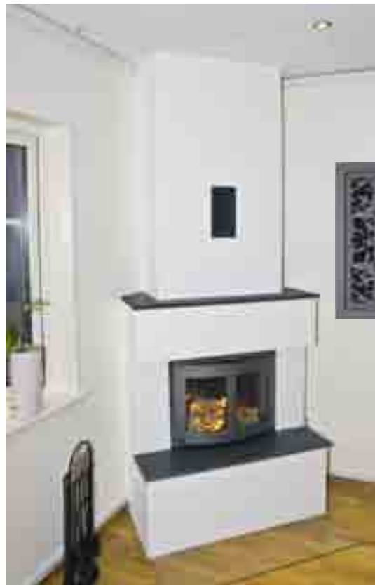
Inte bara en vacker spis utan även unik. Insatsen är en keddy 520 och spisen är murad i lättbetong.
