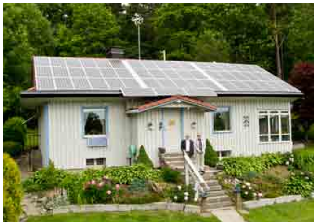
Egen energiproducent. Görans villa i Mölndal är fullt utrustad för att ta emot el från sol och vindkraft på tomten.
