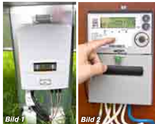
Bild 1 Likströmmen från solfångarna omvandlas till växelström (bild 1), överskottet skickas ut på elnätet (bild 2). Då man är i behov av ström kan man "tanka hem" det man delat ut.
