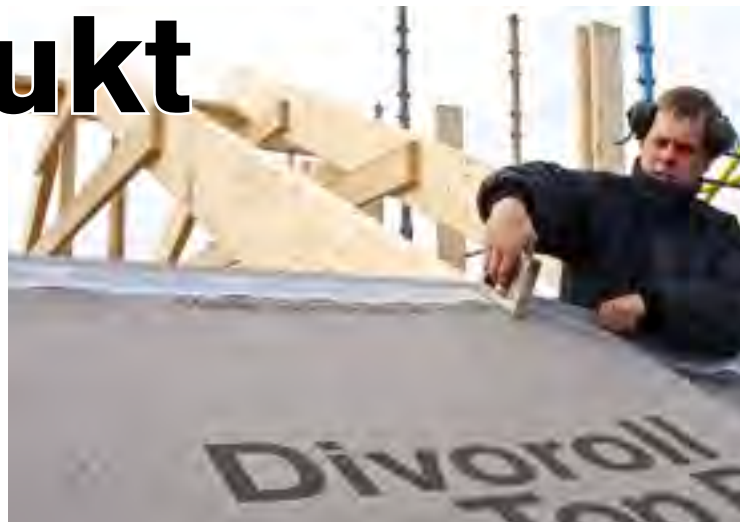
Materialet har förmågan att släppa ut fukt från byggnaden, samtidigt som det skyddar mot nederbörd utifrån.
