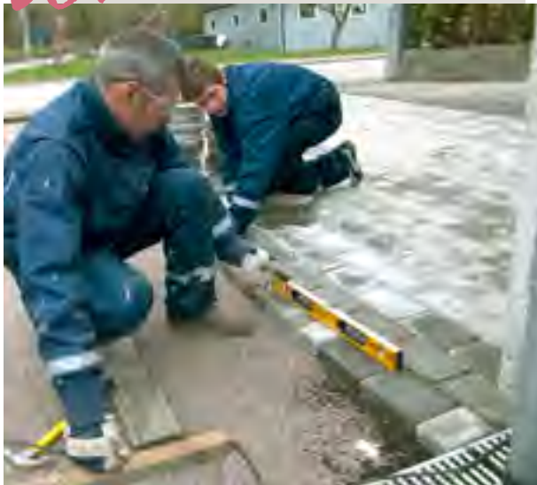
Zeljko Husnjak kontrollerar att fallet ner mot brunnen blir rätt.
