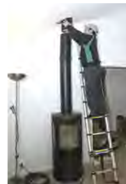
Snart dags att premiärelida. Martin Aderby monterar braskaminen på plats i familjen Skyldbergs vardagsrum.
