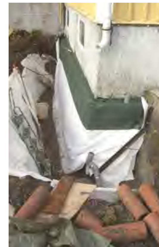
Grävarbete. Kurt har grävt ner dräneringsrör för att avleda vattnet bort från källaren.
