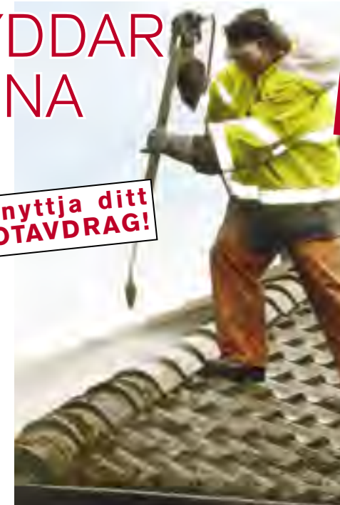
Innan takpannorna impregneras tvättas de först med ett dyny® tegeltvätt som avlägsnar all smuts och påväxt.
