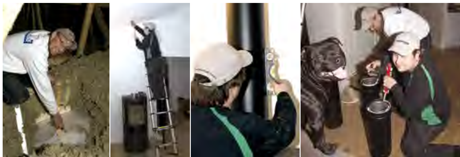
Skorstensmontage. Anders kontrollerar genomföringen i vindsutrymmet medan Martin skär upp innetaket för skorstenen. Hunden Roy ser till att killarna jobbar!
