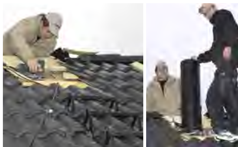
På hög nivå. Takplattorna får ge plats för skorstenen som färdigmonterad reser sig cirka 60 cm övernocken.
