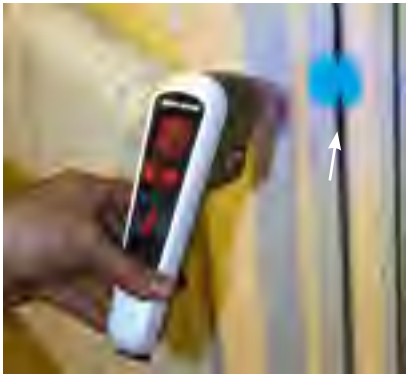
Blått ljus vid en skadad list, där är det ett läckage. Grönt ljus indikerar att det är "grönt", utan större läckage.
