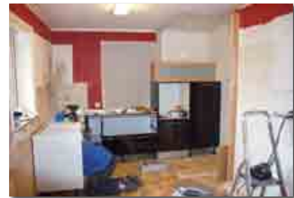
Full fart. Skafferiet borttaget, dörren igensatt, det nya köket på väg in.
