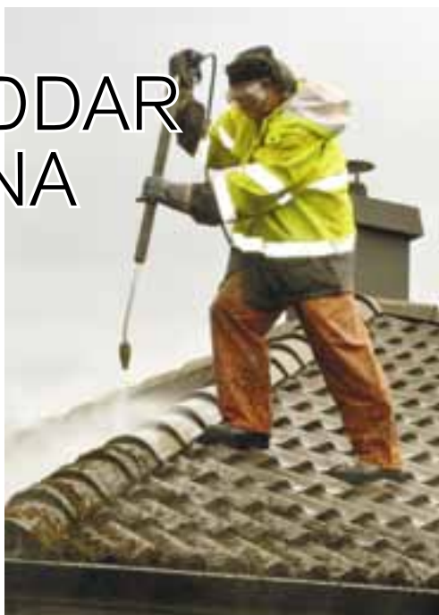
Innan takpannorna impregneras tvättas de först med ett pH-höjande tvättmedel som avlägsnar all smuts och påväxt.
