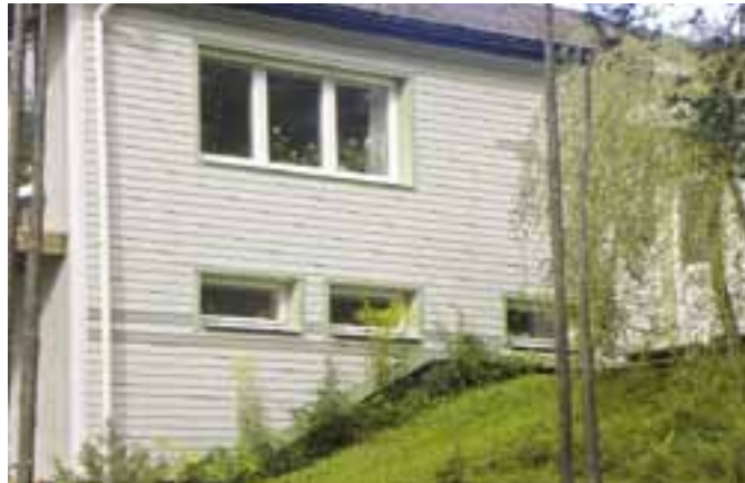
Marmoroc fasad fäst på metallprofiler, en svenspatenterad metod.
