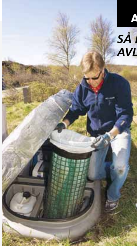
Lättskött kretslopp. I minireningsverket finns en slampåse som Gert byter var tredje månad. Påsen kan enkelt komposteras i trädgården.
