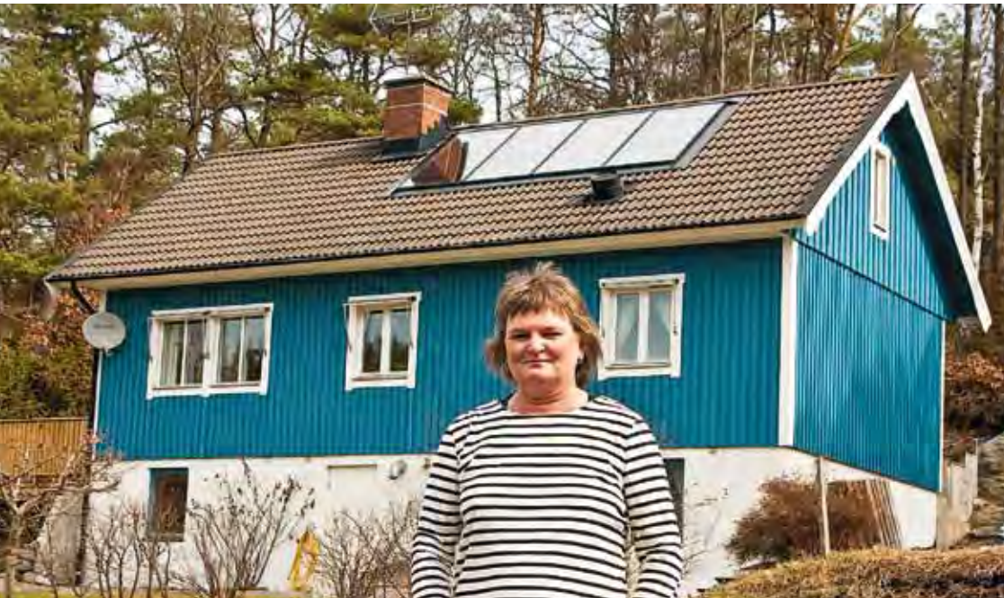
Gynnsamt läge. Anna-Clara Nilsson på Orust tillvaratar solvärmen på södertaket med 4x3 kvm solfångare.
