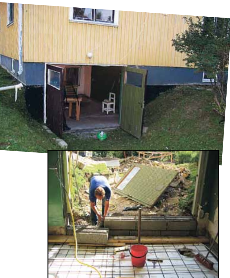
Eftersom takhöjden i garaget bara var knappt 2 meter bilade Jim ut hela betonggolvet och sänkte det cirka 25 cm.
