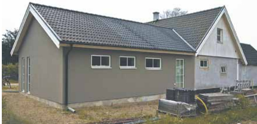
Om man misstänker fuktskador i sin fasad bör man som fastighetsägare kontakta en skadeutredare
