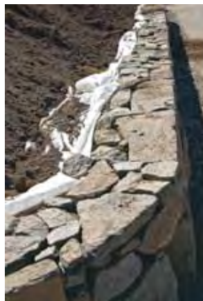
Lägg märke till fiberduken som ligger mellan makadammen och jorden.
