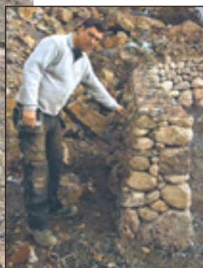
Joacim Dahlqvist vid kullerstensmuren innan man har fyllt igen. Stora bilden: Lagg märke till den stora mängd makadam som har lagts på bakom muren.
