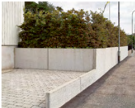
En mur av L-stöd har ersatt den gamla slänten och gjort trädgården nästan 25% större.
