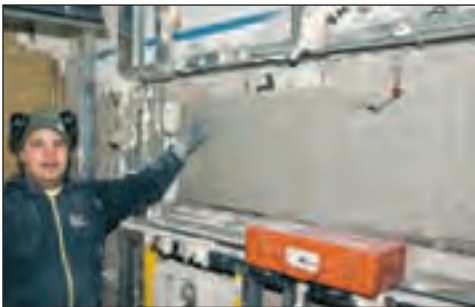
Plattsättare Michel Höglund visar det enda stället där det fanns en tjockare fuktspärr.
