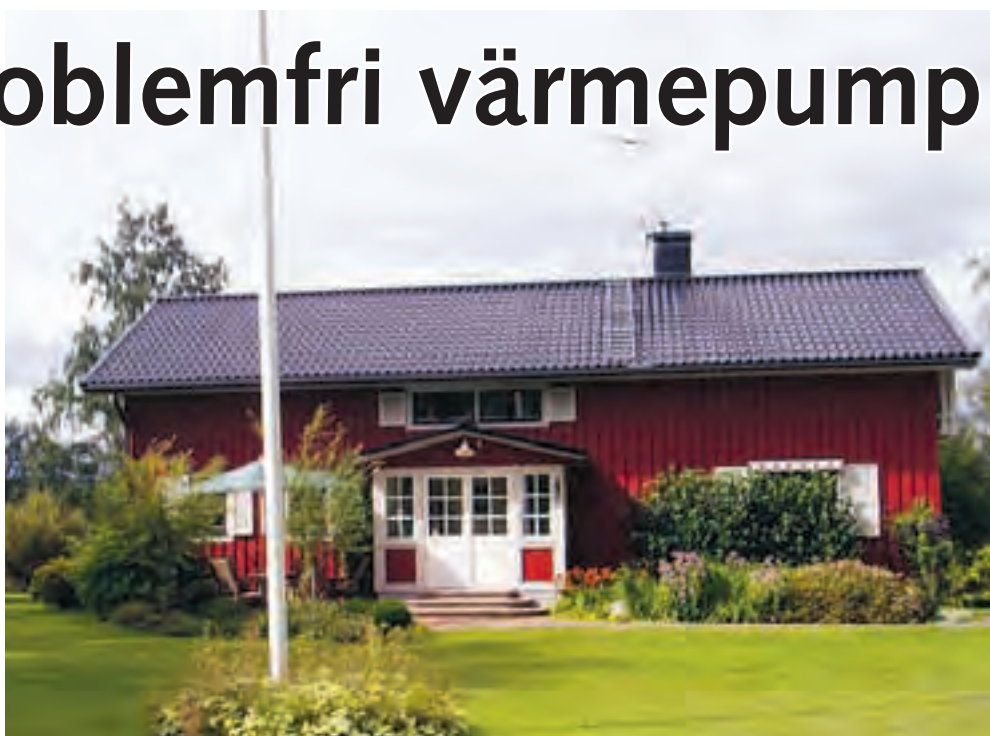
Hans Dahlman valde ytjordvärme som värmekälla, och grävde själv ner 600 meter slang på en meters djup.
