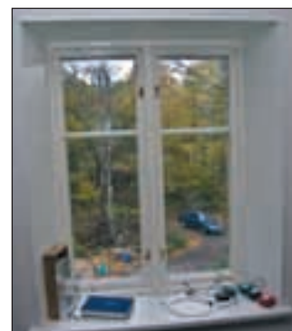
I gammal stil. De djupa fönsternischerna är vinklade utåt för att öka ljusinsläppet.
