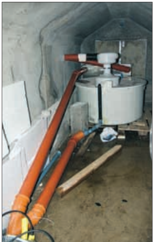
Kretslopp. Med avloppssystemet Aquatron separeras utsläppen från huset och blir till gödning för odlingsmarkerna.
