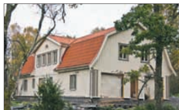
Under byggnation. Om ett år ska det ekologiska huset stå färdigt.
