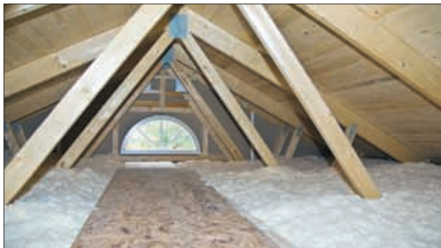
Välisolerat. Krypviden har tätats noggrant mot fukt och försetts med ett tjockt lager träullsisolering.
