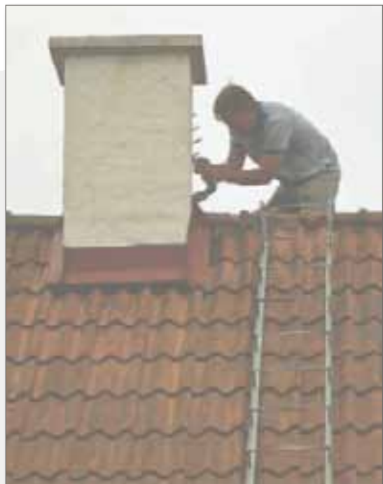
Kontrollera regelbundet känsliga ställen som runt skorstenen, olika genomföringar och fönster – särskilt äldre takfönster.
