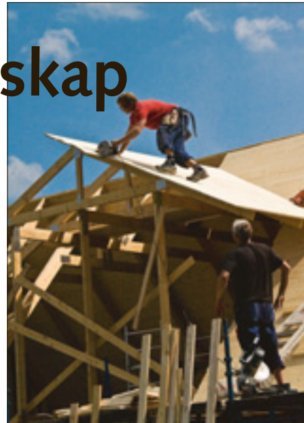
Villaägarnas Riksförbund kräver nu att regeringen stärker konsumentens skydd i samband med upprättande av småhus. (Byggnadsarbetarna på bilden med endast som illustration).
