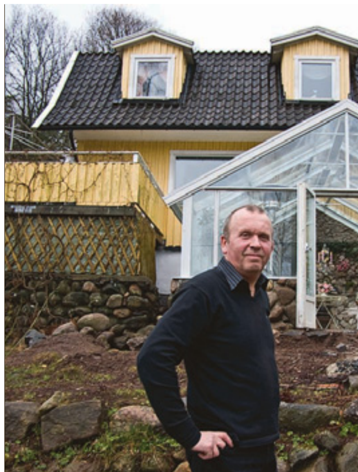
Anders Anderssons kakelugnspanna värmer upp hans villa i Mölnlycke - och den uppvärmda inomhusluften leds ut i den nybyggda växthuset.
