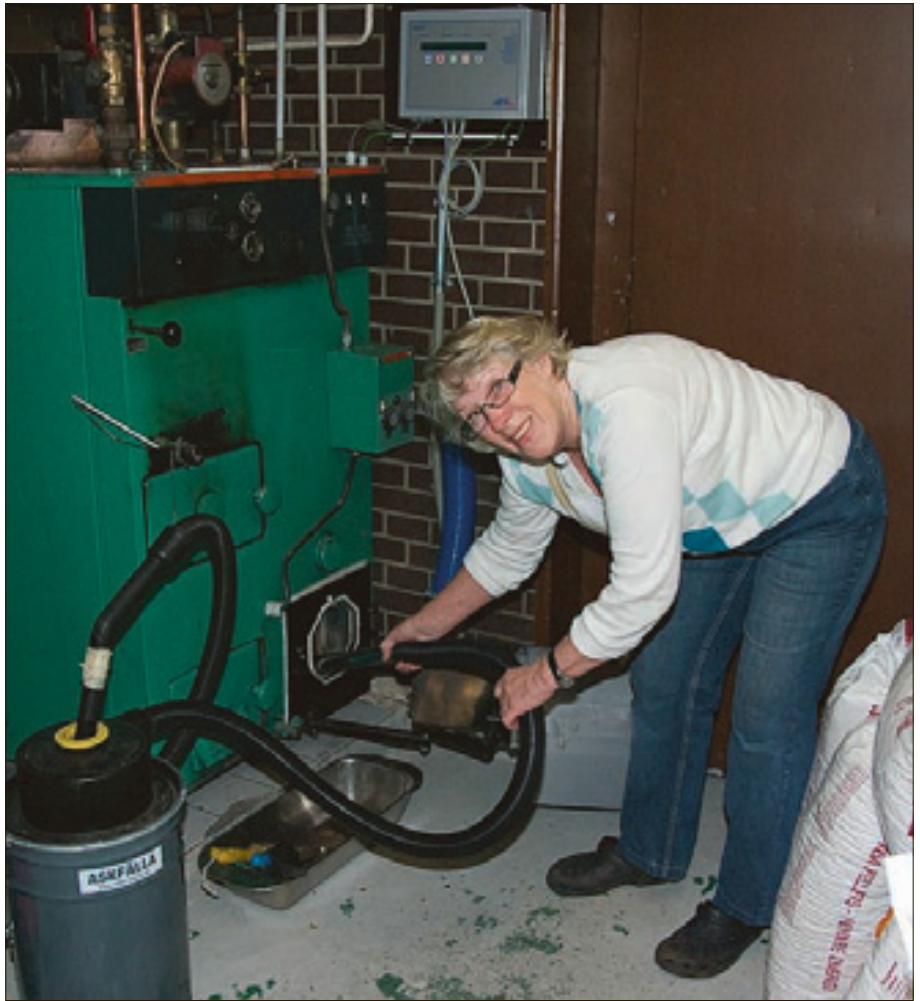
Astrid Lidman har en pelletsbrännare med en avancerad dator som sköter hela förloppet, så hon behöver bara fylla på pellets och aska ur.
