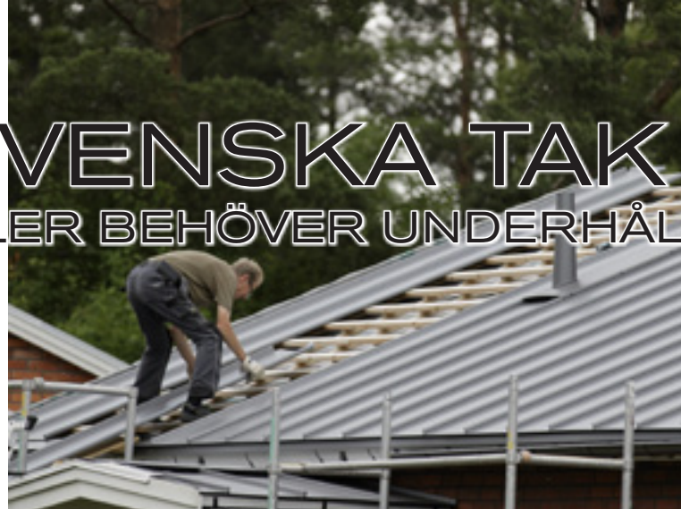
Med underhåll och inspektion av taket, kan takbyten undvikas.
