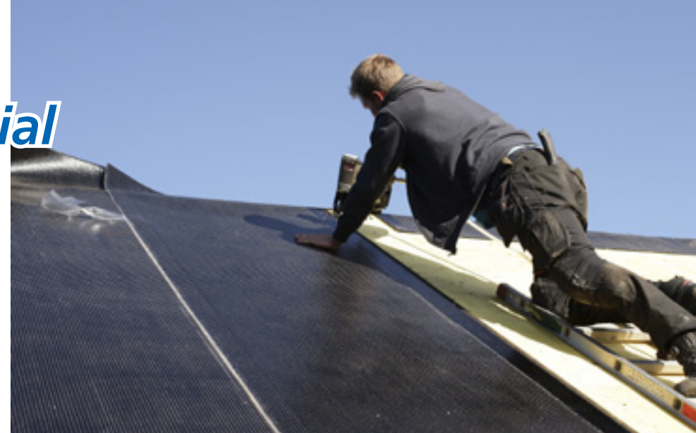
Den nya underlagsduken Matak Haloten T1 är anpassad för både svetsbara och klitrade tätskikt och är halkfri.
