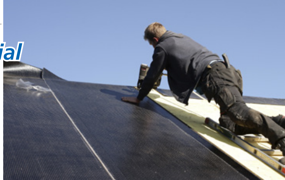
Den nya underlagsduken Mataki Haloten T1 är anpassad för både svetsbara och klistrade tätskikt och är halkfri.
